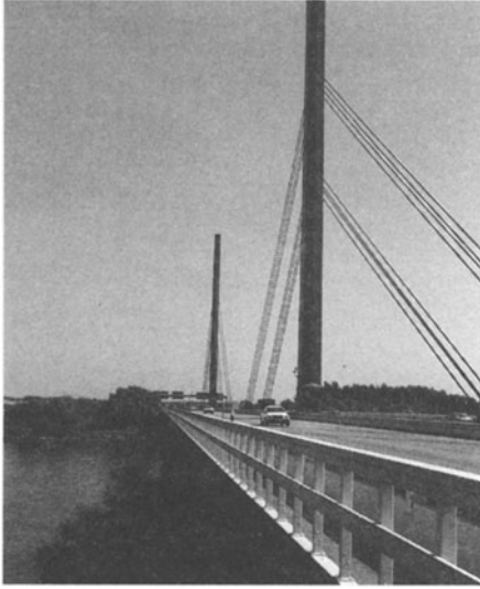
Fig. 6.10. The Norderelb bridge
